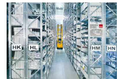
Installations à étages
